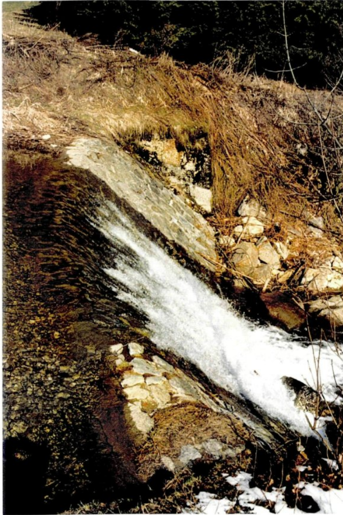
Abb. 9: Das gemauerte Absturzbauwerk des Roiderwehres
