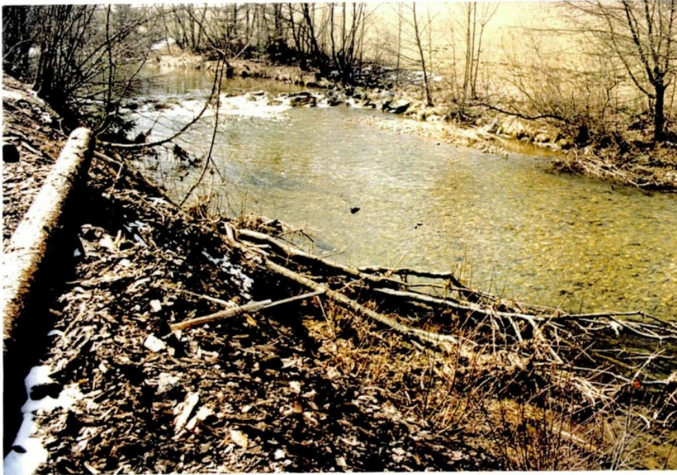
Abb. 13: Sohlschwelle in der Vöckla oberhalb der Wehranlage des Sägewerkes Angern
