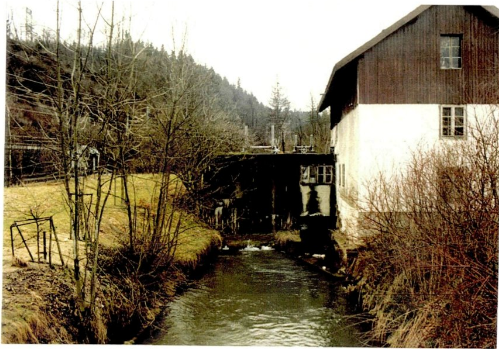
Abb. 34: Auslauf der Wasserkraftanlage Ragererwehr
