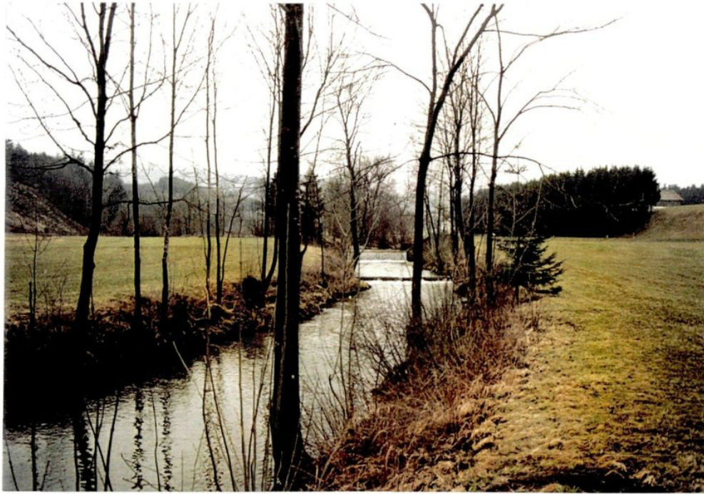
Abb. 22: Das regulierte Flußbett der Vöckla oberhalb des Höllmühlwehres. Zur Minderung der Fließgeschwindigkeit sind in Abständen Sohlwellen eingebaut
