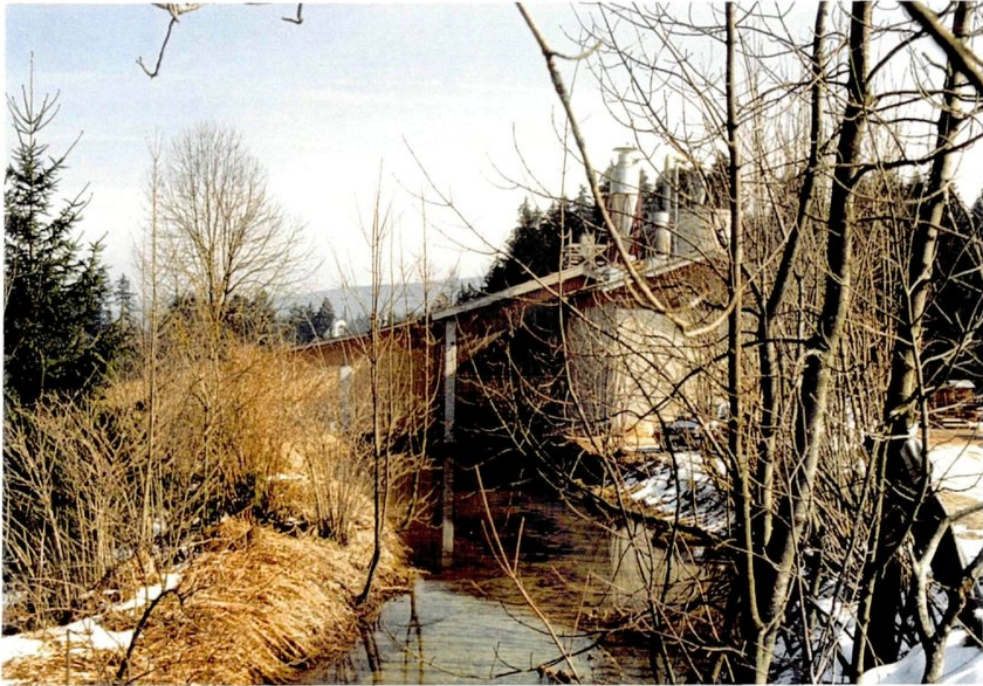
Abb. 10: Einlauf in das Turbinenhaus der Sagerermühle
