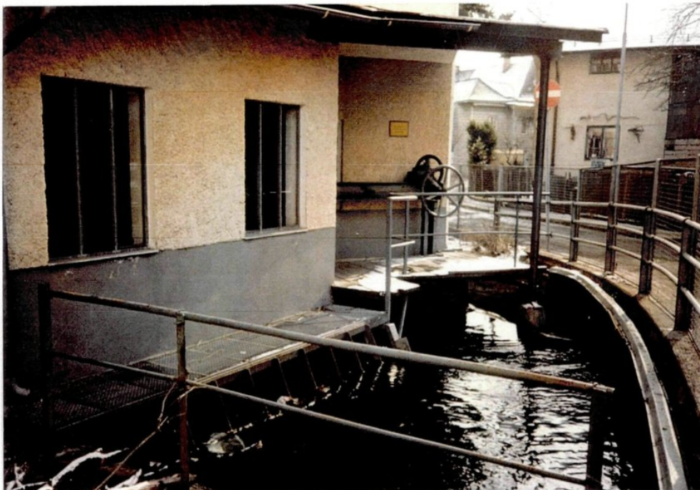
Abb. 54: Einlauf in das Turbinenhaus der Vöcklabrucker Kunstmühle
