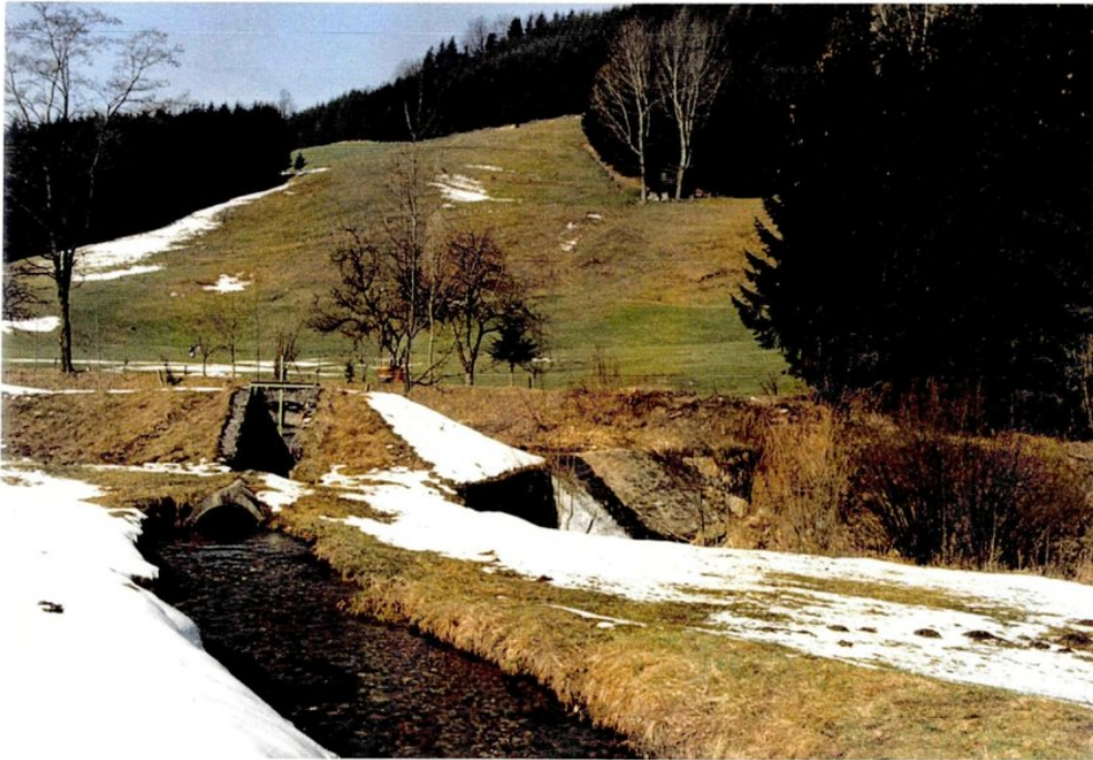
Abb. 8: Die Ausleitung des Mühlbaches am Roiderwehr
