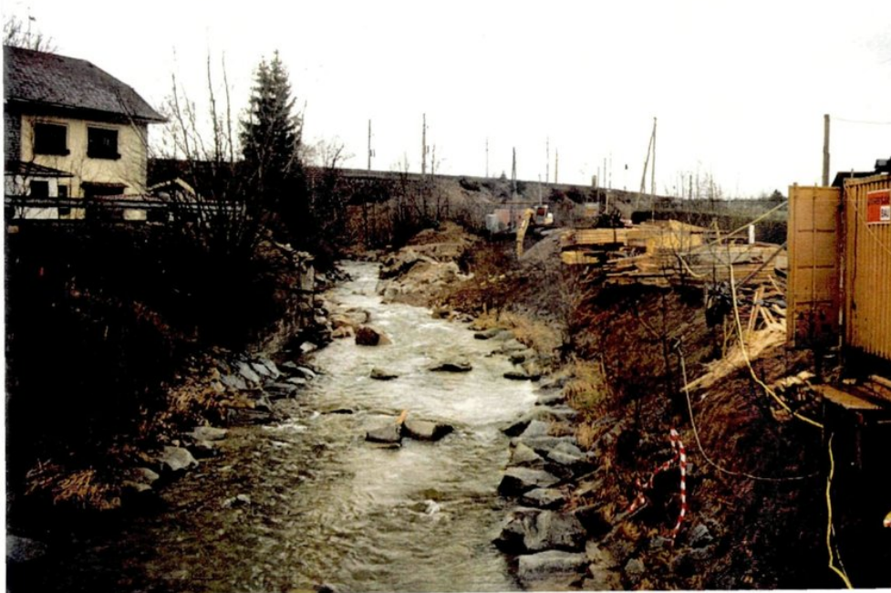
Abb. 26: Neubau der Brücke der Bundesstraße 1 über die Vöckla in Schwaigern (März 1993)
