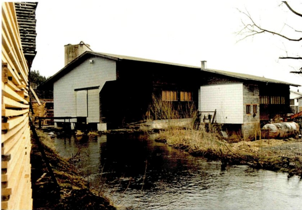
Abb. 36: Sägewerk am Mühlbach des Steinernen Wehres
