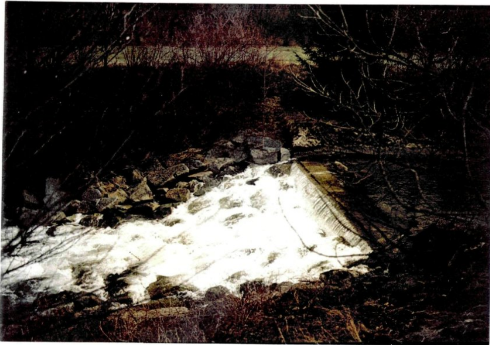
Abb. 25: Gegenschwelle des Karlmühlwehres, daran anschließend eine Rampe aus Granitwurf (kein bodenständiges Material)
