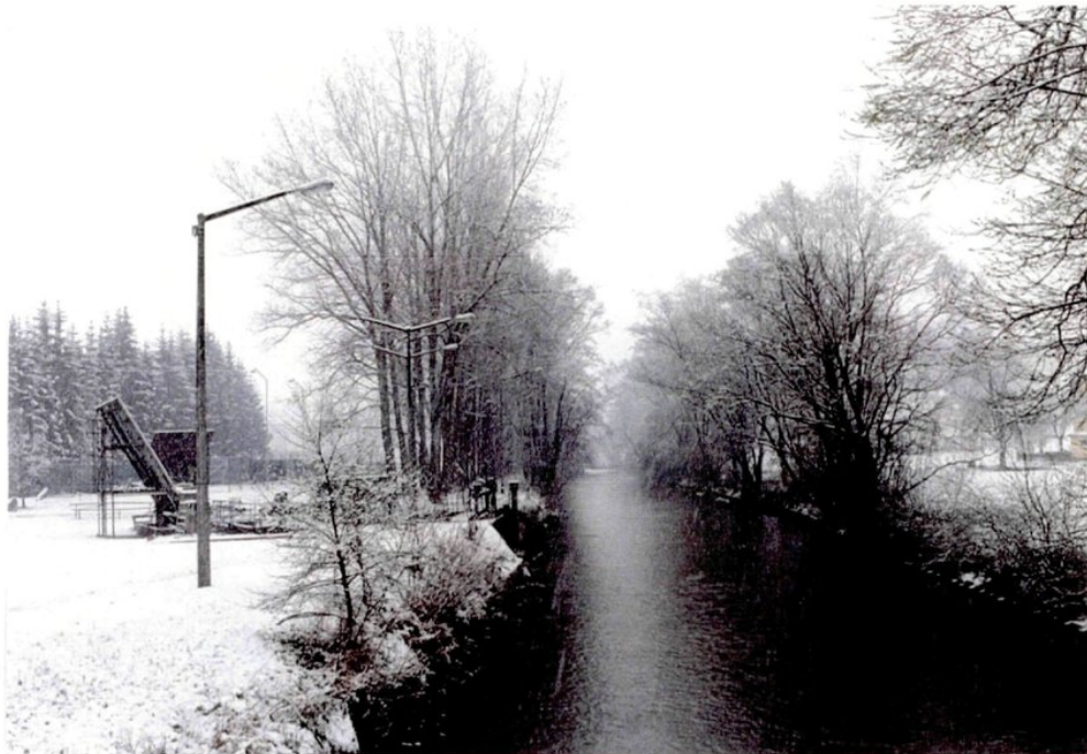
Abb. 48: Das regulierte und mittels Mann-an-Mann-Pilotagen gesicherte Flußbett der Vöckla oberhalb der OKA-Wehranlage
