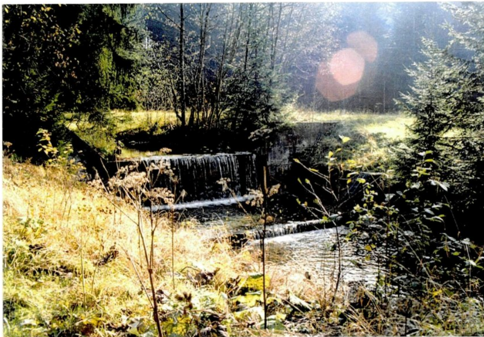
Abb. 3: Die massive Wehranlage der Harpointsäge
