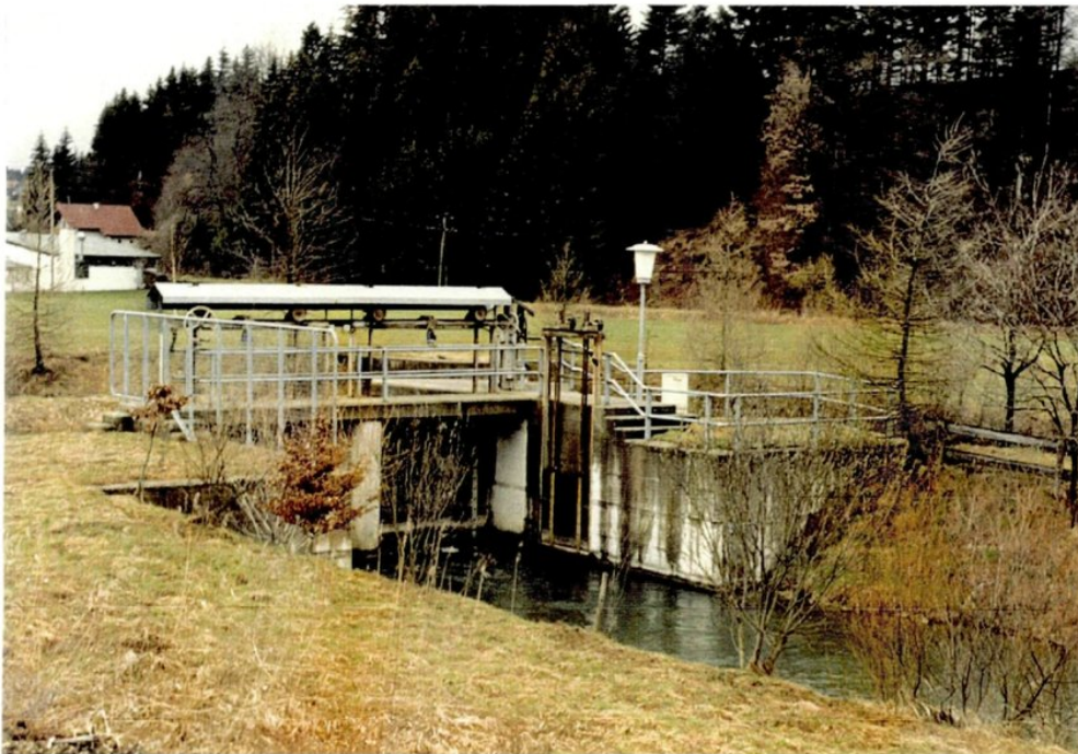
Abb. 31: Die durch Schützentafeln regulierbare Ausleitungsstelle des Mühlbaches am Trenauerwehr
