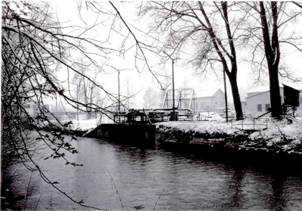
Abb. 47: Ausleitungsbauwerk zum OKA-Kraftwerk Timelkam
